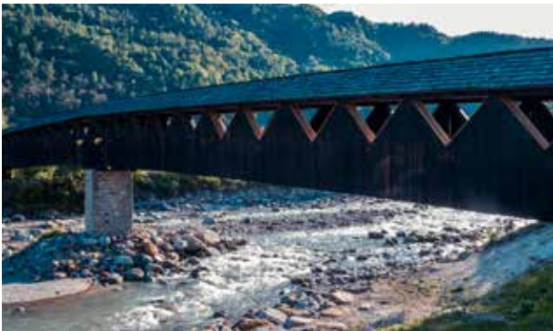
Alte Holzbrücke über die Etsch
